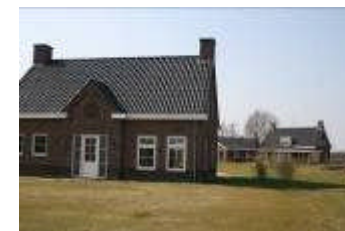
Nieuw gerealiseerde woningen
