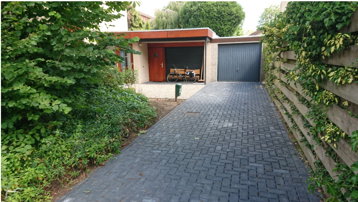
Afbeelding 24 Samenwerking gemeente en particulier: waterpasserende verharding bij particulier en gemeente
