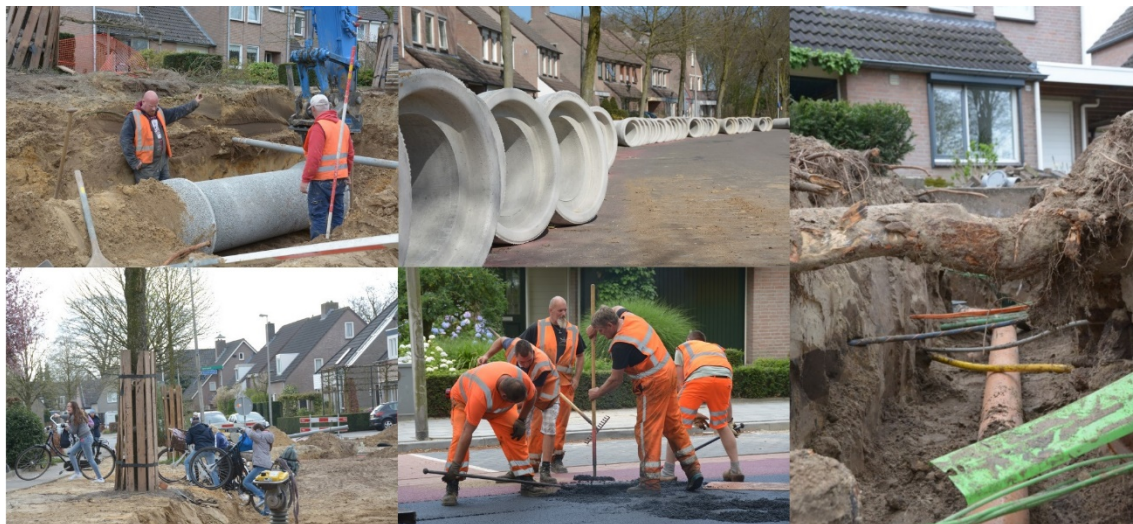
Afbeelding 25 Riolervervanging en aanleg IT-riool Heerbaan
