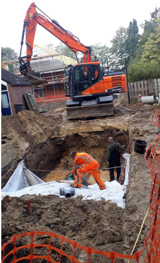
Afbeelding 21 Aanleg IT-riool met lavakoffer in het Spicaplein
