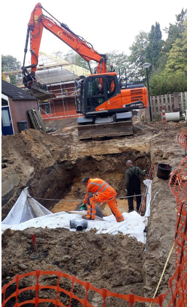
Afbeelding 21 Aanleg IT-riool met lavakoffer in het Spicaplein
