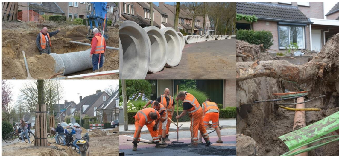
Afbeelding 25 Riolervervanging en aanleg IT-riool Heerbaan
