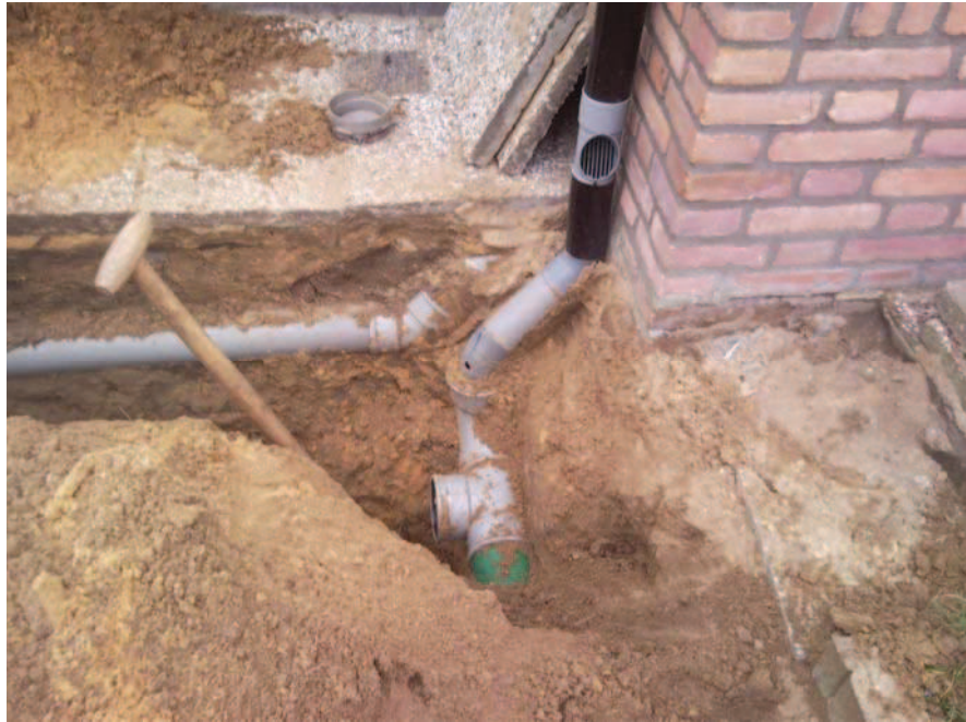
Foto 5.6 Afkoppelen regenwater Mgr. Den Dubbeldenstraat
