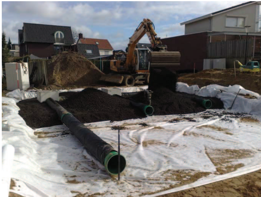
Foto 5.5 Aanleg infiltratiekoffer Zagershof
