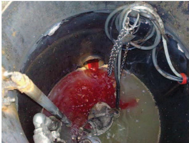
Foto 6.5 Controle hemelwater op drukriolering
