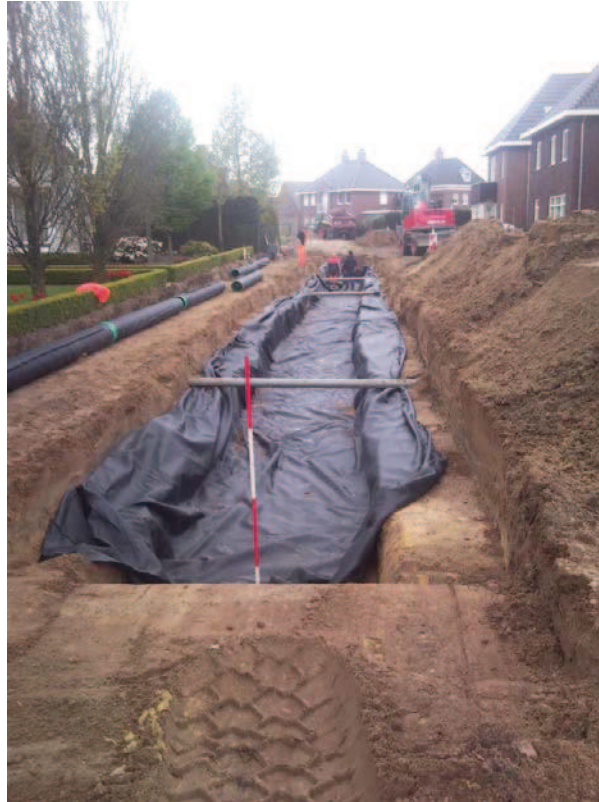
Foto 6.4 Aanleg lavakoffer en IT riool Mistweg
