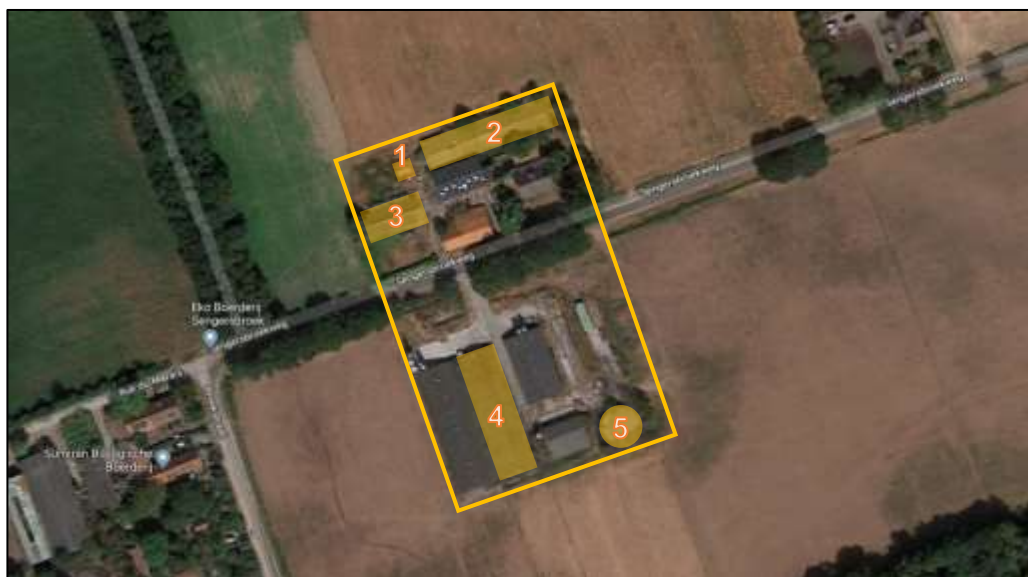
Figuur 2. Globale begrenzing plangebied (gele lijn) de te slopen gebouwen zijn geel gearceerd (bron: Google Maps)
