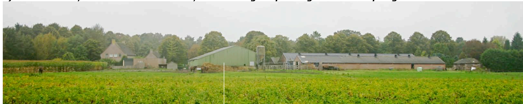
4) Inzoem vanaf de ten oosten gelegen veldweg; een open zicht op de aanwezige bebouwing
