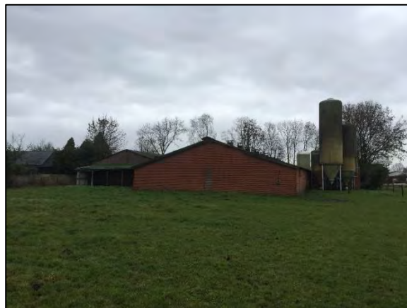
Foto 2. Stallen in het plangebied (links blijft behouden, rechts wordt gesloopt)
