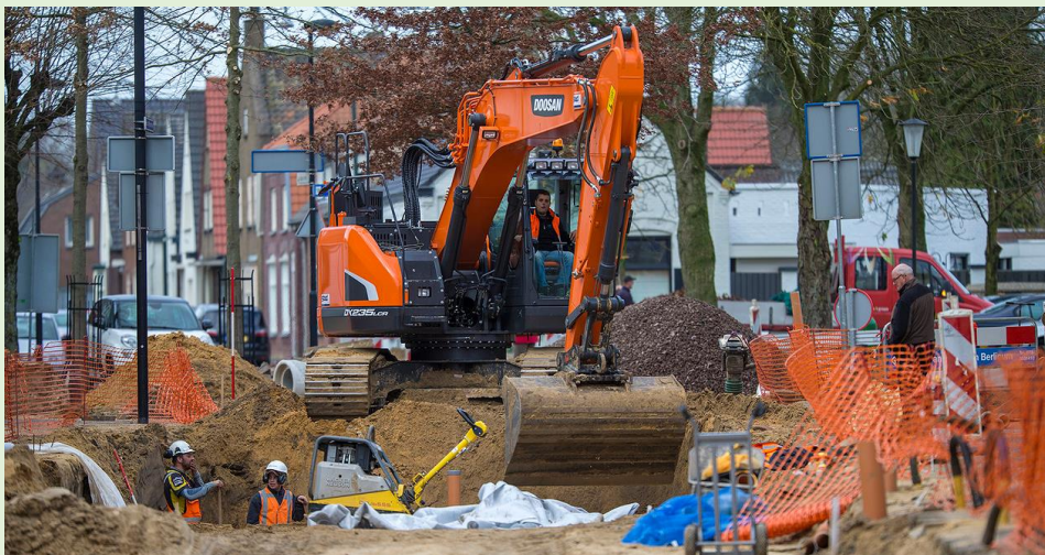
Rioolwerkzaamheden in de Burgemeester Wijnenstraat (foto: SIRIS)
