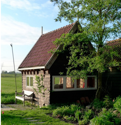
Vrijstaand bijgebouw voorzien van een zadeldak. Zorgvuldig materiaalgebruik en detaillering.
