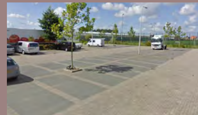
Versteende parkeerplaats Bron: Google Streetview
