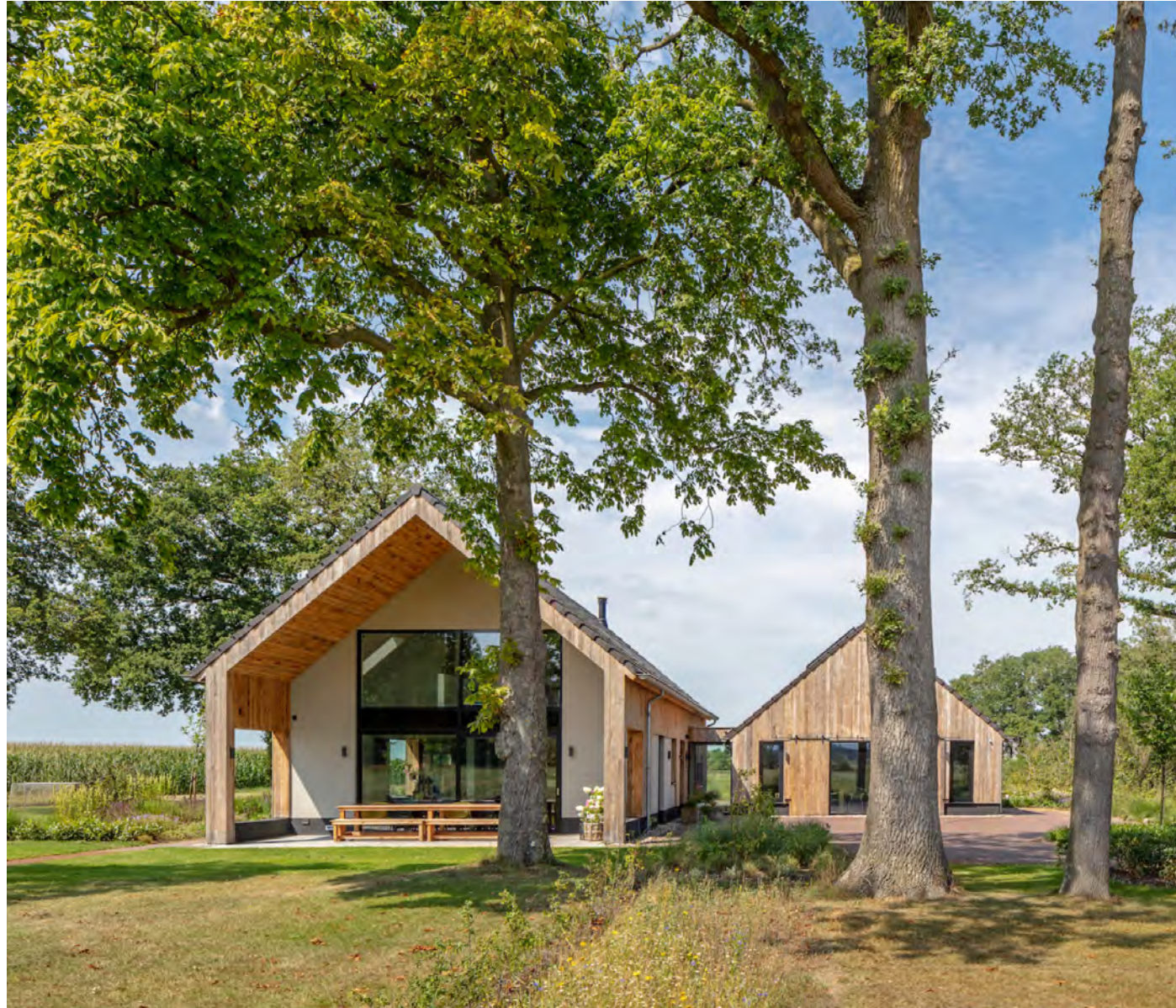
Impressie moderne woning met kantoorshuur Bron: Schipperdouwes architectuur
