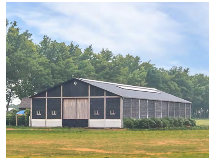
Moderne landelijke schuur met hout, Deurne
